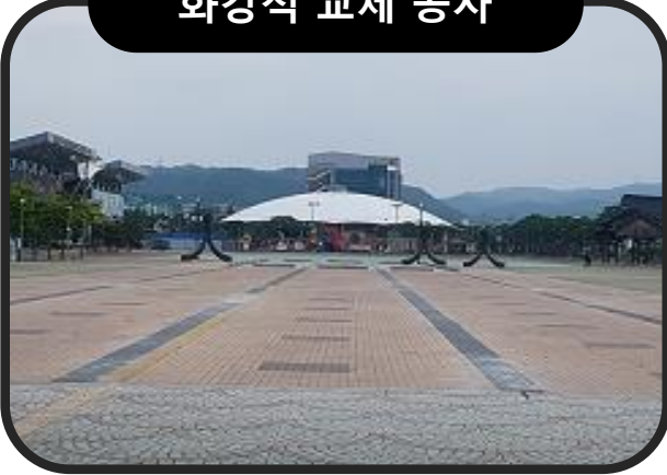
화강석 교체 공사
